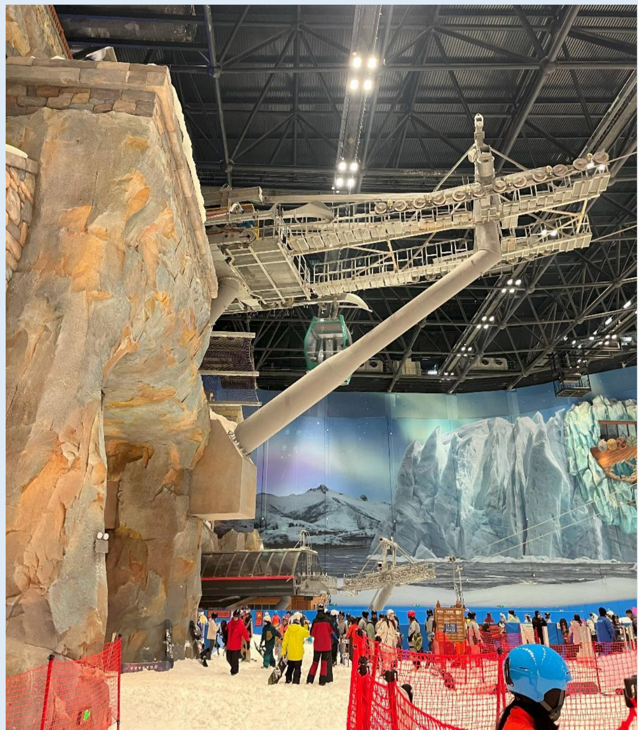
▲スキーコースのスペースを最大限に確保するため、1号支柱基礎は壁にあり支柱も斜めになっている。
